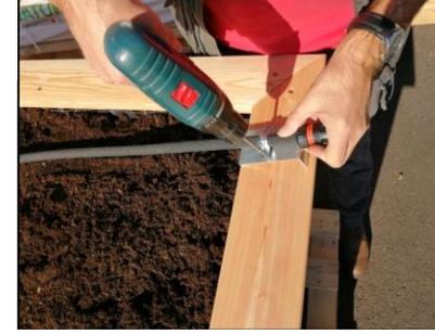
Mit der Schelle den Schlauch und die Winkel am Handlauf befestigen. Schrauben in die vorgebohrten Löcher setzen und festziehen.
